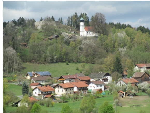
Burgruine mit Wallfahrtskirche
